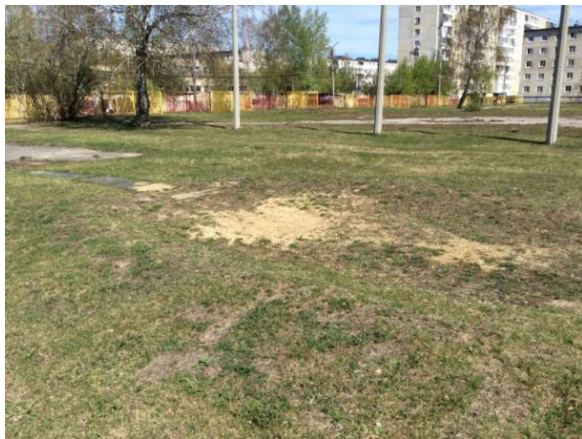
Рис. 6. Запущенное плоскостное сооружение для прыжков в длину по ул. Лермонтова в г. Каменск-Уральский.
